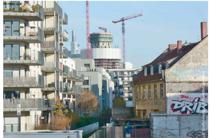
Blick zur Baustelle des Wohnhochhaus „GRAND Tower“
