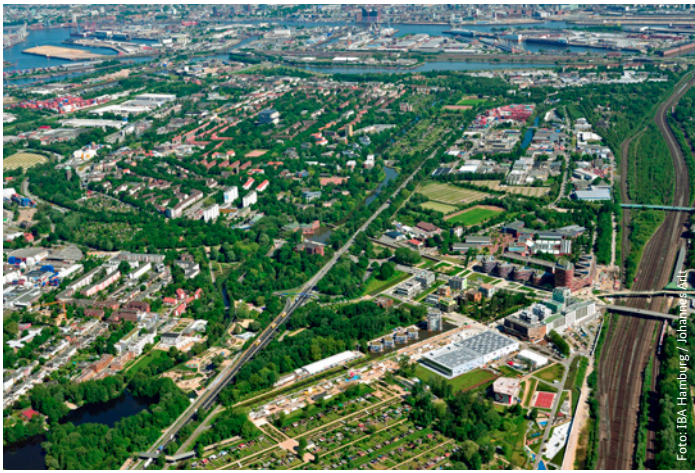
Das IBA-Gebiet Wilhelmsburg-Mitte
